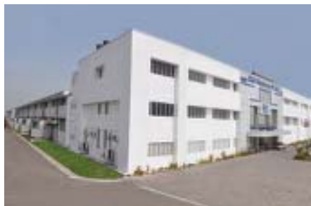
CONTROLS & SWITCHGEAR HIMOINSA Pvt. Ltd
