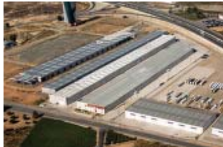
HIMOINSA T. OF METAL 2
